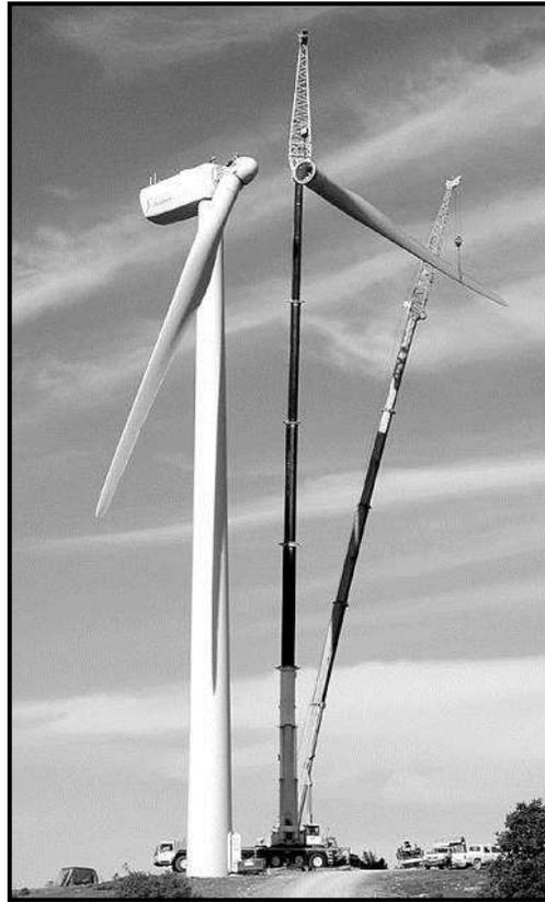
Foto II.1. Vista del área de montaje de la torre y la turbina y del espacio necesario para maniobras.
