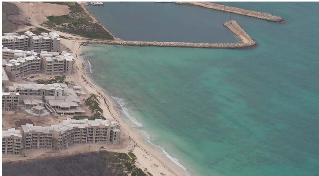
Figura 32. Fotografía del 12 de marzo del 2008, se observa la arena acumulada frente a los edificios, la cual erosionó hacia la playa en junio del mismo año.
