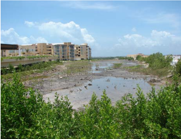
Figura 36. Vista de norte a sur, se observa la situación actual en el límite oeste del predio, donde se realizó reforestación con manglar alrededor de la cuenca temporal.
